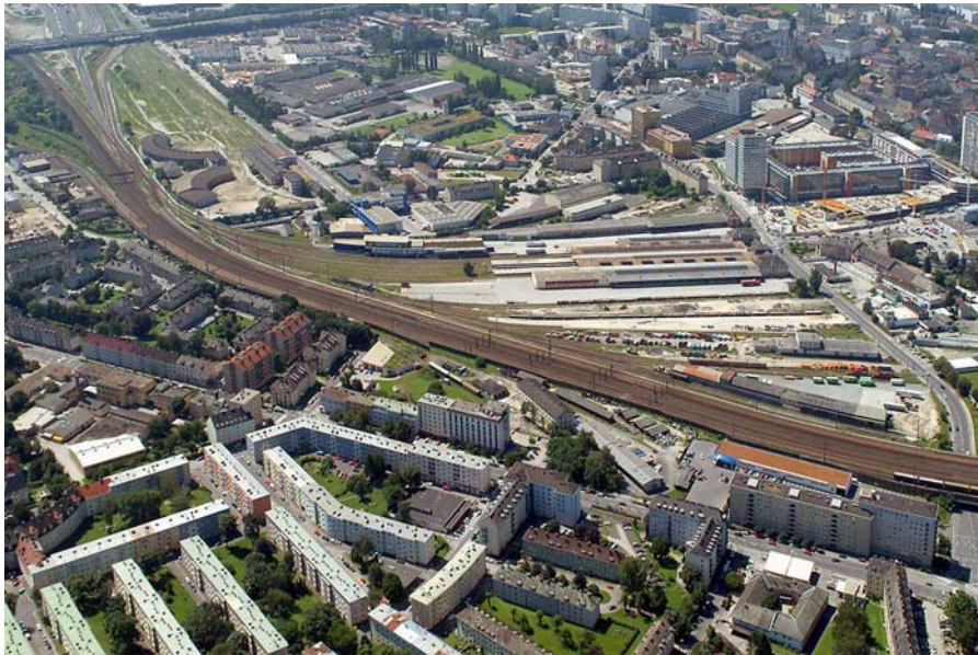
Abbildung 4: Luftbild Frachtenbahnhof Linz – Planungsgebiet Trendzone Linz Mitte
