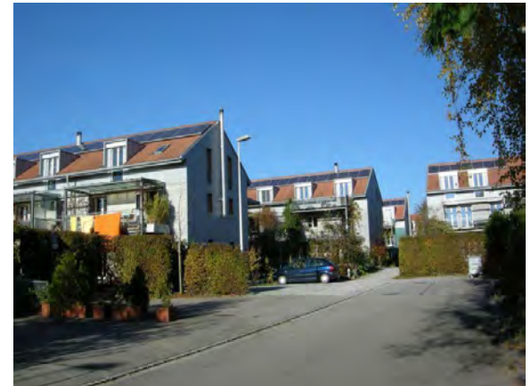
35 kWp PV-Anlage Strassweid, Köniz, CH
