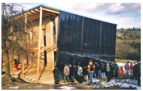
Abb. 8-9: Montage von Fassadenkollektoren der Testfassade einer Holzständerkonstruktion. Fotos: Bergmann/AEE INTEC
