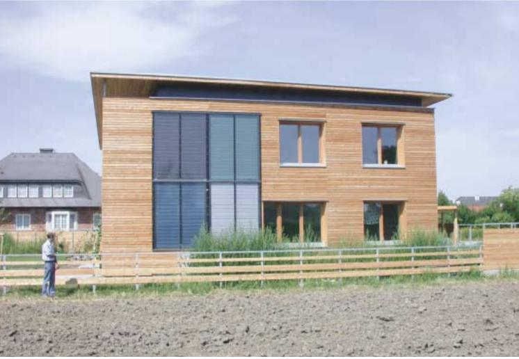
Abb. 2: Wohnhaus Zelger, farbige Fassadenkollektoren. Foto: Müller/AEE INTEC
