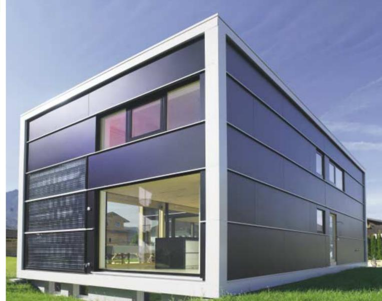
Abb. 1: Architekten Achammer & Partner, Einfamilienhaus mit integriertem Großflächenkollektor, Nenzing. Foto: AKS Doma Solartechnik
