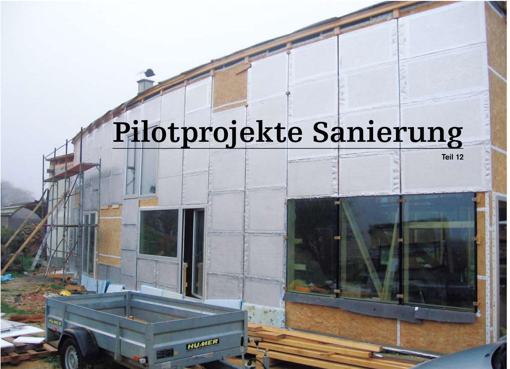
Abb. 1: Sanierung eines alten Bauernhauses mit Vakuum-Isolationspaneelen auf Passivhausstandard, Montage der Paneele, Schleißheim bei Wels. Projektleitung: TB Emanuel Panic. Foto: Panic
