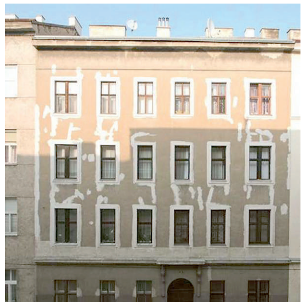
Abb. 5: Demoprojekt Eberlgasse, erste Sanierung auf Passivhausstandard in Wien (Foto: Kronberger)
