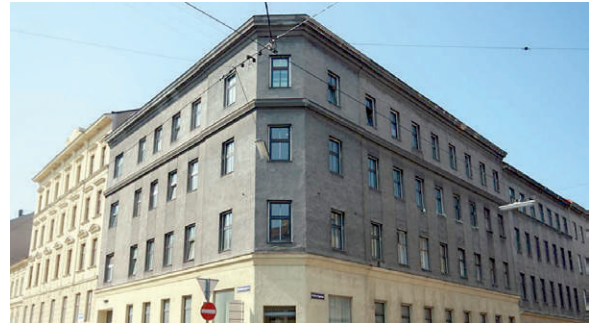
Abb. 3: Demoprojekt David's Corner: Sanierung eines Gründerzeitensembles (Foto: Condominium)
