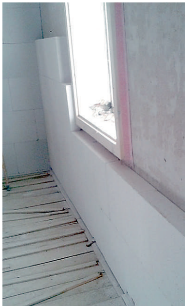
Abb. 8: Demonstrationsprojekt Kaiserstraße: Ausführung der Innendämmung (Foto: Kronreif_Trimmel & Partner)
