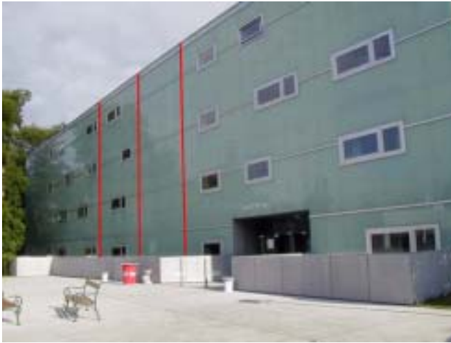
Abb. 15 Südfassade Ansicht mit eingetragem Messfeld „Fenster“
