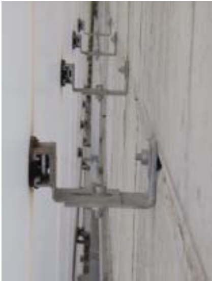
Abb. 19 Südfassade: Fassadenzwischenraum im Bereich Stahlbetonwand (links) und im Bereich Fensterelement mit geschlossenen und geöffneten Sonnenschutzlamellen (rechts)
