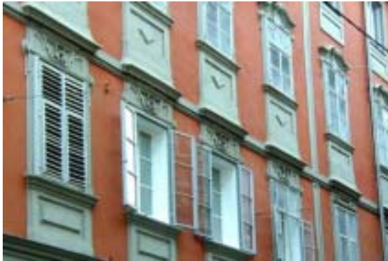
Abb. 2 Kastenfenster in der Grazer Altstadt. Die äußeren Scheiben können im Sommer durch Holzläden ersetzt werden. Zwischen den beiden Glasebenen können nachträglich Sonnenschutzeinrichtungen eingebaut werden [Foto: Hengsberger]
