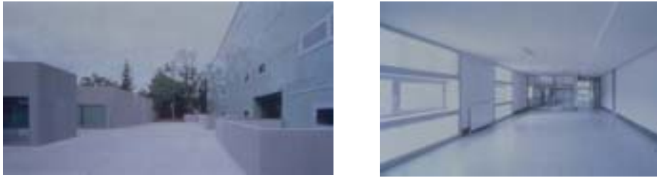
Abb. 17 Südfassade Ansicht gegen Westen und von innen. Die Glasflächen über und unter den Fensterkästen sind mit drehbaren Sonnenschutzlamellen versehen.
