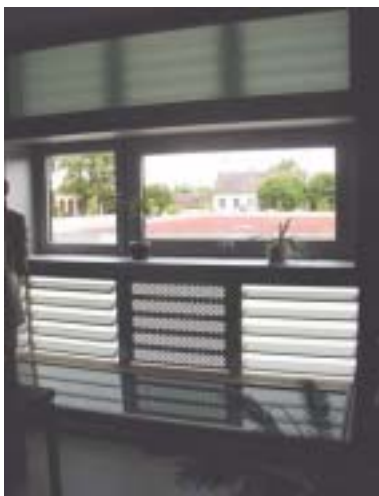
Abb. 45 Ansicht Fensterbereich von innen mit Sonnenschutzlamellen ober- und unterhalb des „Fensterkastens“
