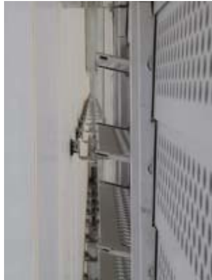
Abb. 19 Südfassade: Fassadenzwischenraum im Bereich Stahlbetonwand (links) und im Bereich Fensterelement mit geschlossenen und geöffneten Sonnenschutzlamellen (rechts)
