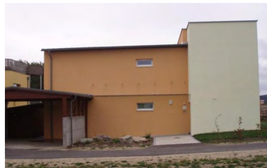
Nordseite eines Passivhauses kleine und wenige Glasflächen
