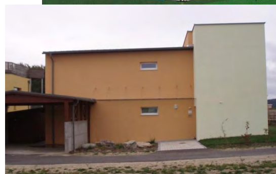
Nordseite eines Passivhauses kleine und wenige Glasflächen
