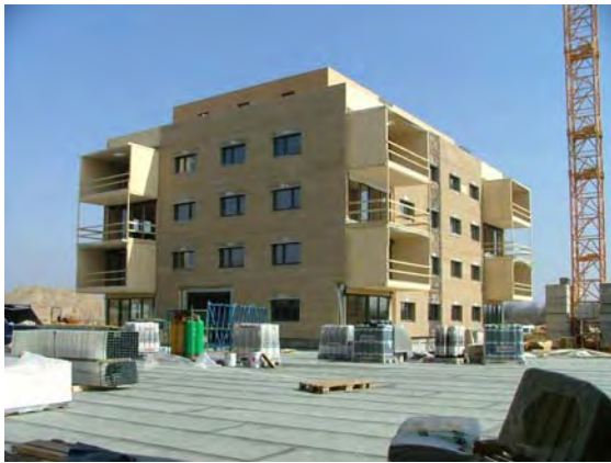
24.03.2006: Haus C, Montage Fertigteile abgeschlossen
