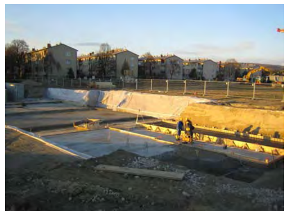
17.11.2005: Betonieren der Bodenplatte Haus C
