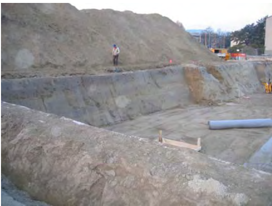
11.11.2005: Baugrube Haus D
