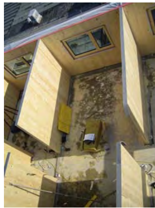
14.02.2006: Wände bereit zur Montage der Decke Fugenbänder
