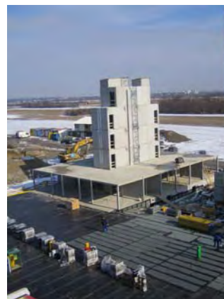
14.02.2006: Haus C bereit für die Montage
