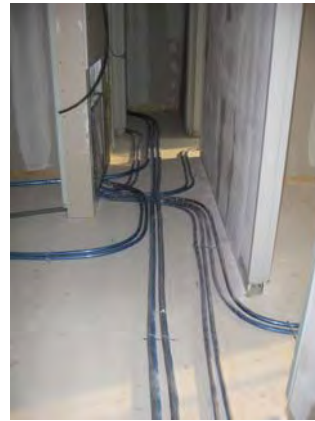
26.04.2006: Bodeninstallation (Heizung)
