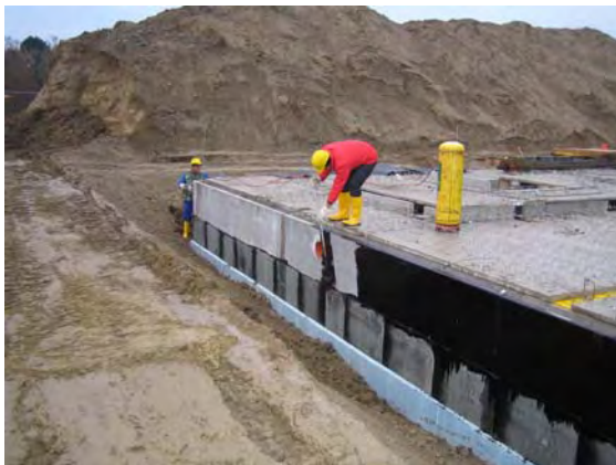
07.12.2005: Voranstrich, Hochziehen der Dichtung Haus D
