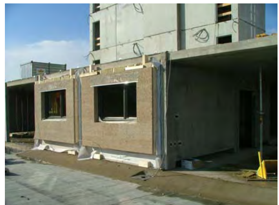
09.02.2006: Haus A – Montage der ersten Fertigteile im EG
