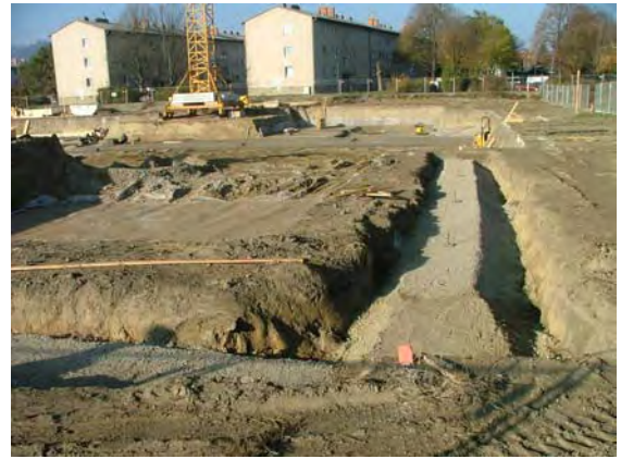
08.11.2005: Pfahlrost Haus D
