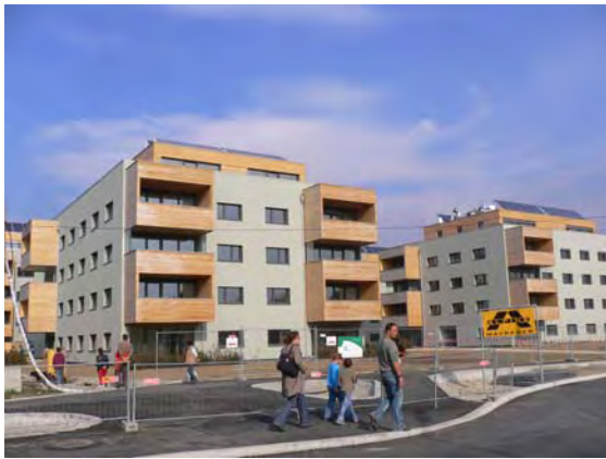
22.10.2006: Anlage kurz vor Fertigstellung
