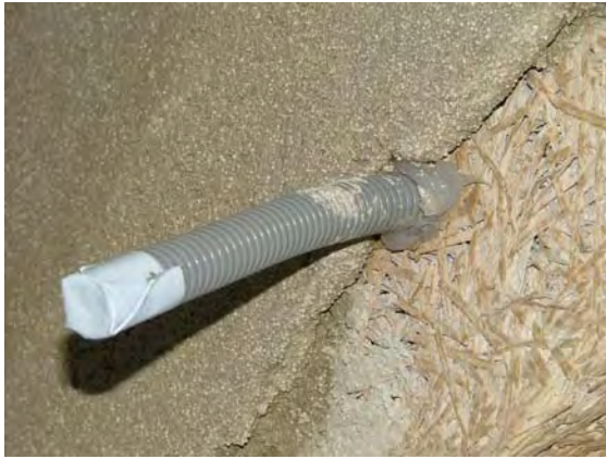
01.02.2006: Musterfertigteile: luftdichte Elektrodurchführung
