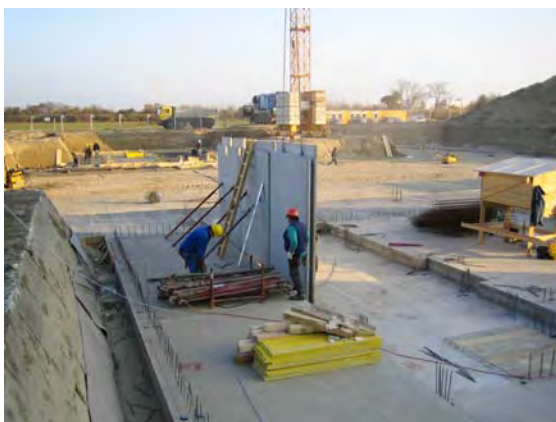
15.11.2005: Aufstellen der Treppenhausefertigteile Haus B
