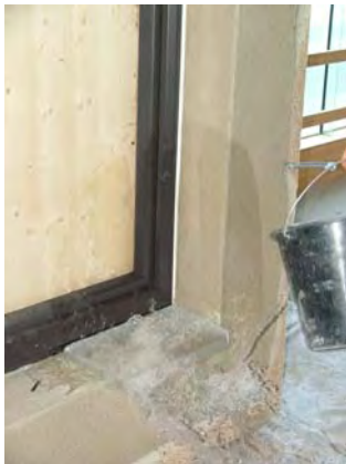
01.02.2006: Musterfertigteile: Prüfung „Schlagregendichtheit“
