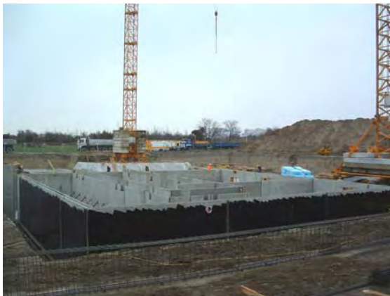
21.11.2005: Kellerwände Haus B, Bewehrung der Pfahlrostschürze
