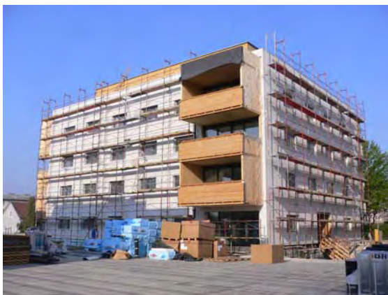
05.05.2006: Haus A eingerüstet, Verputzarbeiten
