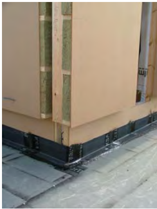
24.02.2006: Detail Aussenecke am DG nach Montage mit Montageabdichtung
