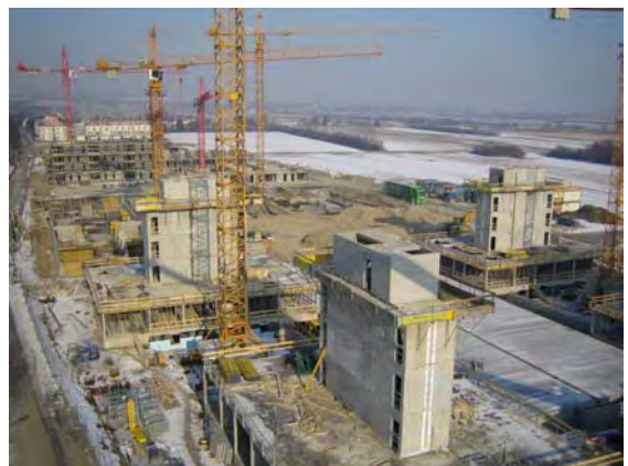
24.01.2006: Bauplätze A, B und (der eigene) C
