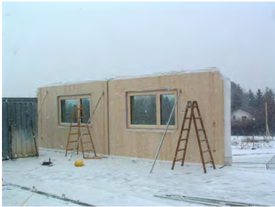
13.02.2006: Montage der Regelgeschosse (auch bei Schneefall)
