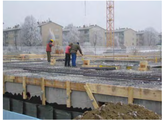
02.12.2005: Halbfertigteile Decke über UG, Haus D
