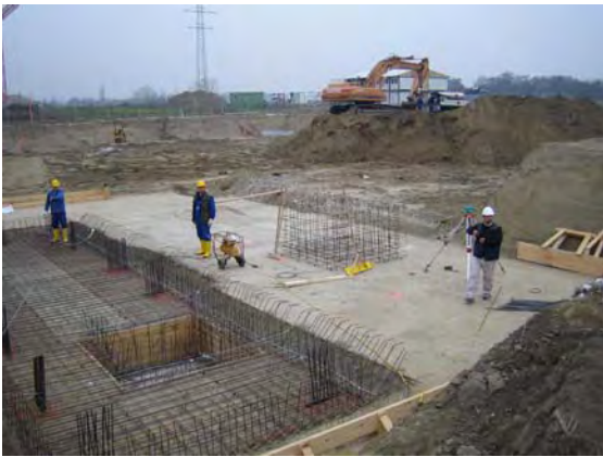
07.11.2005: Sauberkeitsschicht Haus A, bewehren der Bodenplatte Treppenhaus mit Aufzugsunterfahrt
