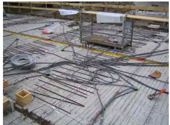
14.12.2005: Leerverrogrund Decke über UG
