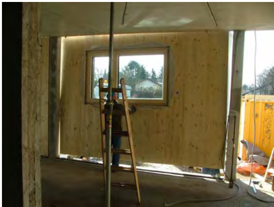
09.02.2006: Heben in die Montageposition
