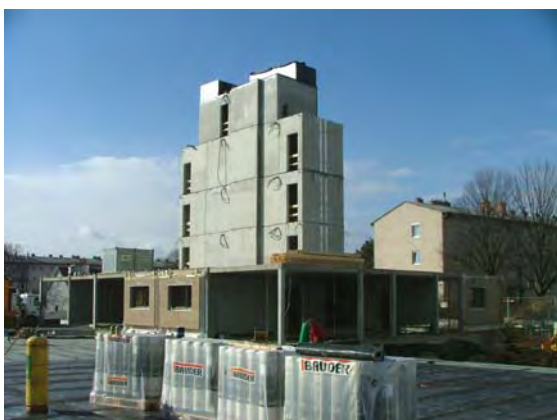
09.02.2006: Haus A – Montage der ersten Fertigteile
