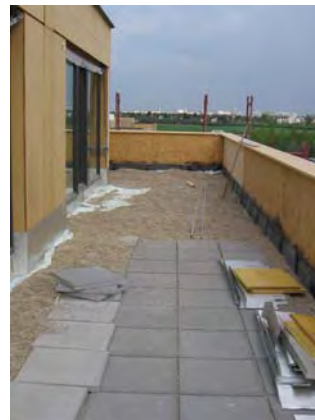
26.04.2006: DG Terrassenbelag in Arbeit
