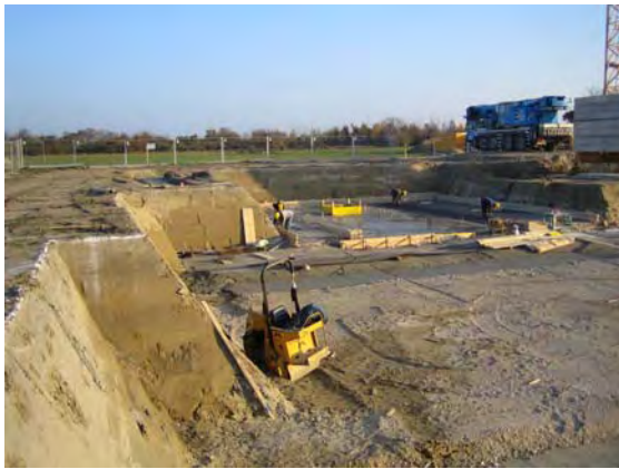
15.11.2005: Herstellen Niveau für Bodenplatte TG
