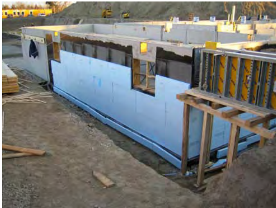
17.11.2005: Dichten und Dämmen UG Haus A
