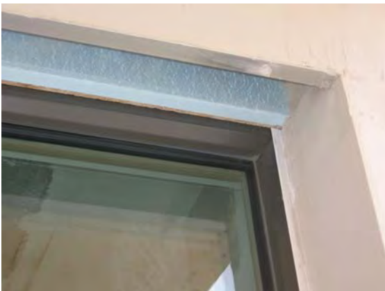
26.04.2006: Detail Fenstersturz vor Einbau der Jalousiekästen
