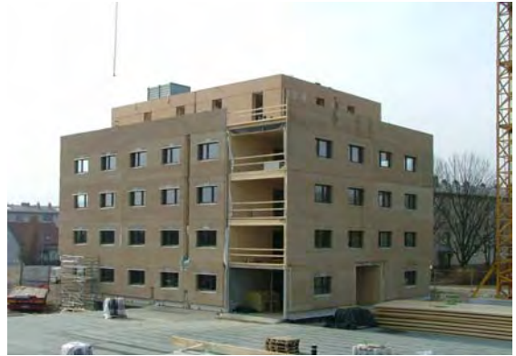
24.02.2006: Haus A – Montage der Fertigteile fertig (ausgenommen Loggien)
