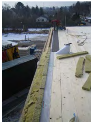
15.02.2006: Nachbearbeitung am Detail Fassade - Decke
