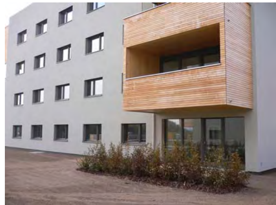
22.10.2006: Haus A – Terrasse, Loggia
