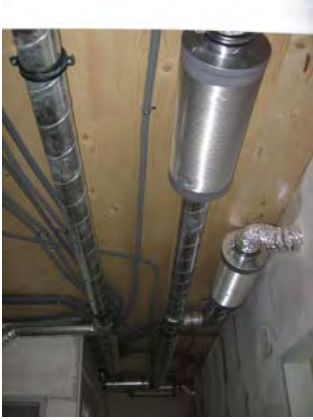
26.04.2006: Deckeninstallation, Schalldämpfer
