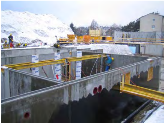
30.11.2005: Schalungsarbeiten Decke über UG, Haus D
