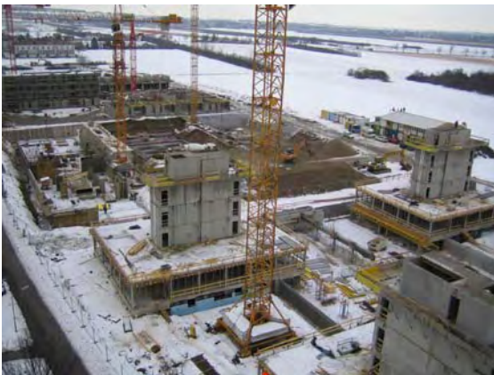
18.01.2006: Bauplätze A, B und (der eigene) C
