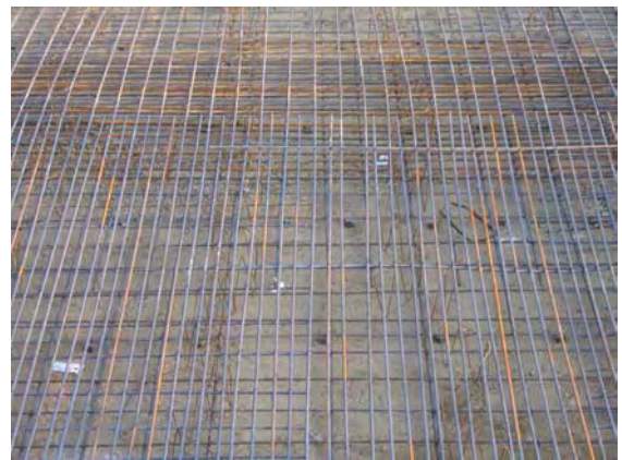
11.11.2005: Bewehrung Bodenplatte
