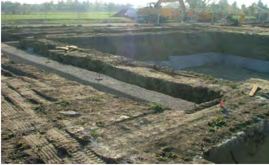
08.11.2005: Pfahlrost Haus D
