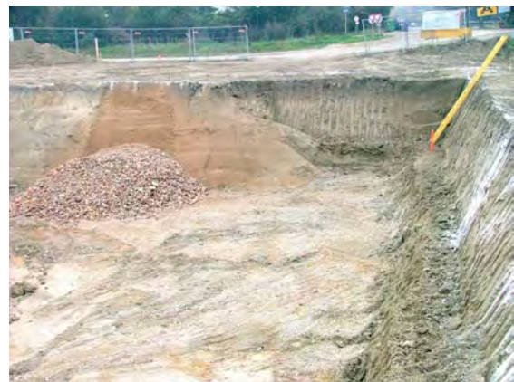
20.10.2005: Baugrubenaushub auf tragfähige Schicht, Bodenaustausch
