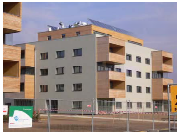
22.10.2006: Haus D – am Dach Sonnenkollektoren u. TGA
