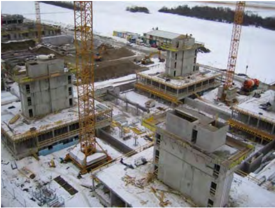
18.01.2006: Treppenhäuser Haus A, B und C
