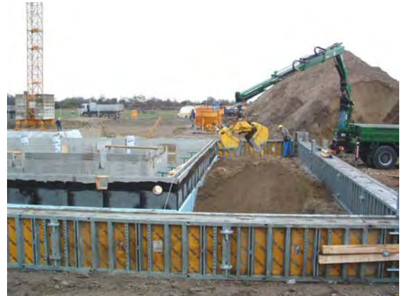
21.11.2005: Hinterfüllen zw. UG und Schürze der Pfahlroste Haus A
