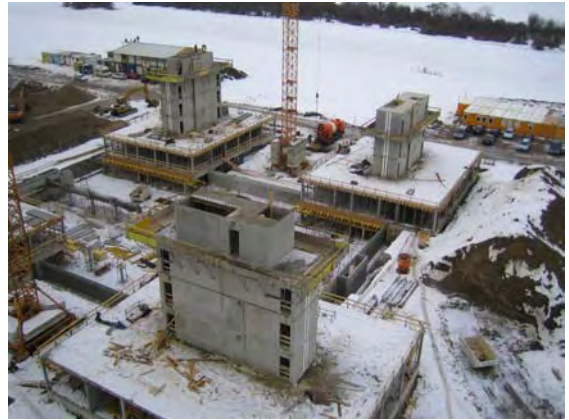
18.01.2006: Treppenhäuser Haus A, C und D
