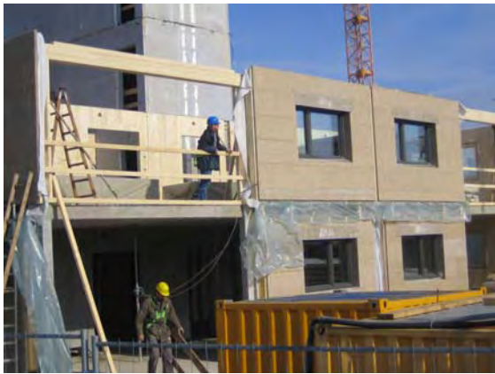
14.02.2006: Holzüberzug im Bereich der großen Verglasungen
