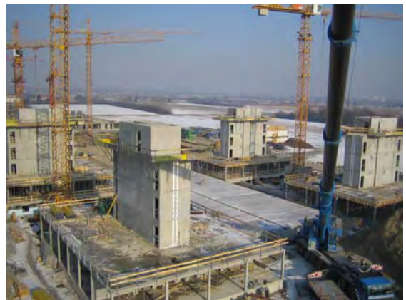
24.01.2006: Treppenhäuser mit gedeckter Tiefgarage
