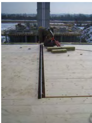
15.02.2006: Nachbearbeitung am Detail Wohnungstrennwand - Decke
