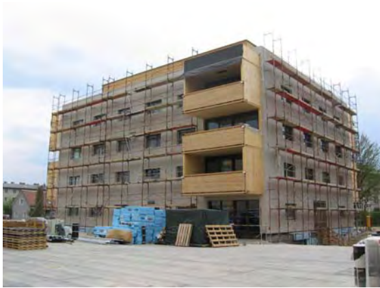
26.04.2006: Haus A eingerüstet, Verputzarbeiten
