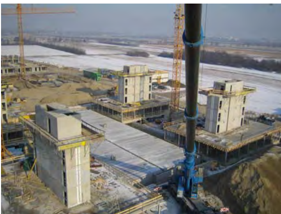
24.01.2006: Treppenhäuser mit gedeckter Tiefgarage
