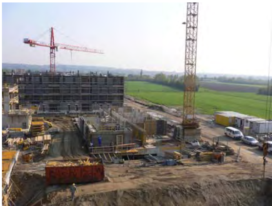
05.05.2006: Bauplatz B – Blick ins Marchfeld
