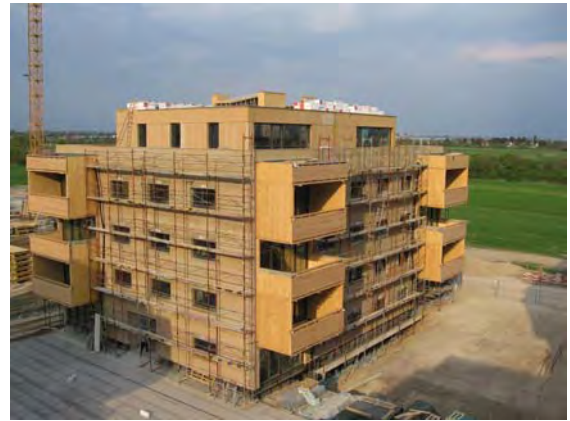
26.04.2006: Haus C eingerüstet
