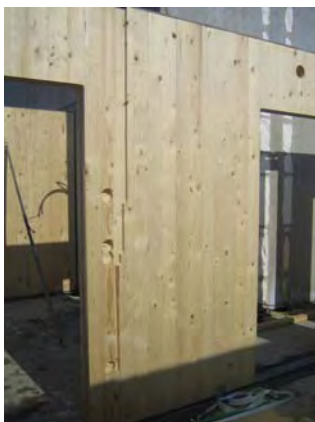
14.02.2006: Fräsungen für die Elektroverkabelung
