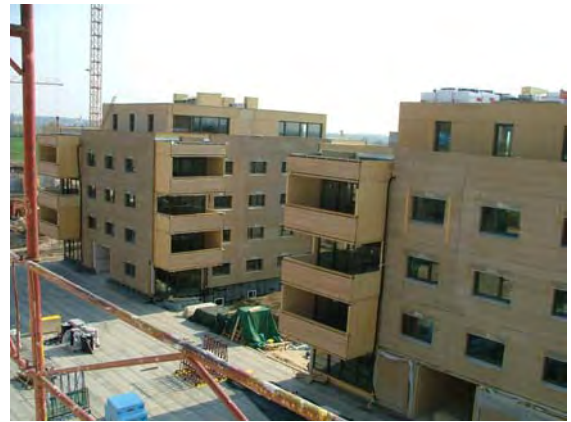
20.04.2006: Haus C,D, Montage Fertigteile abgeschlossen
