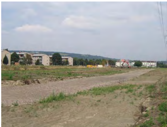
19.08.2005: Herstellen der Höhenlage der neuen Erschließungsstraße, Blick in Richtung Bisamberg
