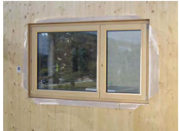
14.02.2006: Strömungsdichter Fenstereinbau werkseitig links mittig sieht man das Prüfsiegel für das Fertigteil
