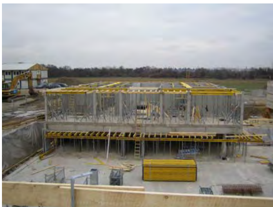
14.12.2005: Schalungsarbeiten Decke über EG Haus C
