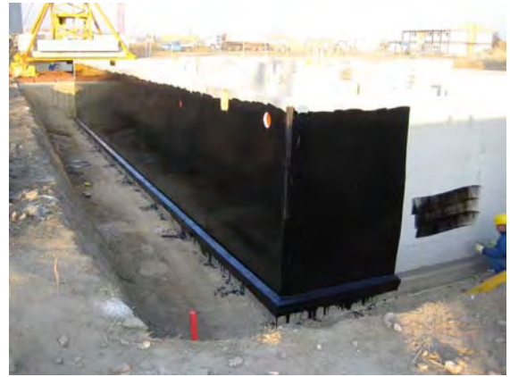
15.11.2005: Kellerwände Haus A, Voranstrich
