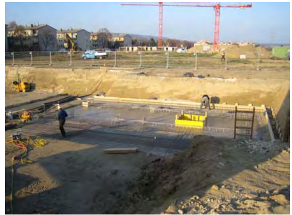
15.11.2005: Betonieren der Bodenplatte Haus C
