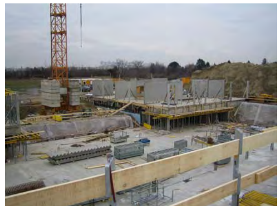
14.12.2005: Wände und Säulen EG Haus D
