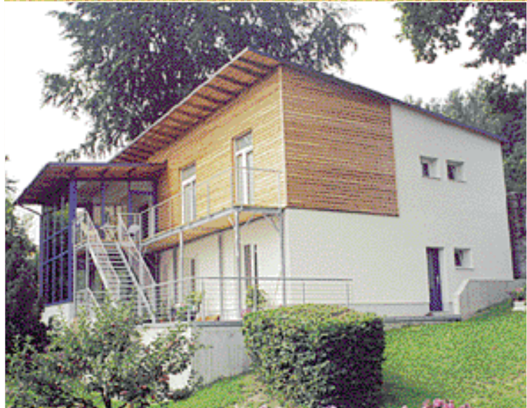
Pasivní dům v Rapottensteinu, smíšená konstrukce. Dům získal od dolnorakouské vlády ocenění Energyglobe 2000
