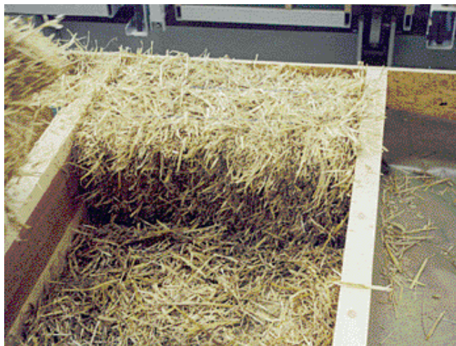
Příprava dřevěné konstrukce se slámovou izolací v dílně. Při správném použití je sláma cenově výhodnou alternativou běžných izolačních materiálů
