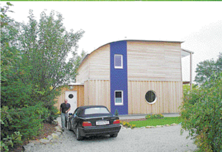
Nízkoenergetický dům v Dolním Rakousku, kompaktní stavba a velkorysá otevření k jihu. Na dolním obrázku pohled na stejný dům od západu
