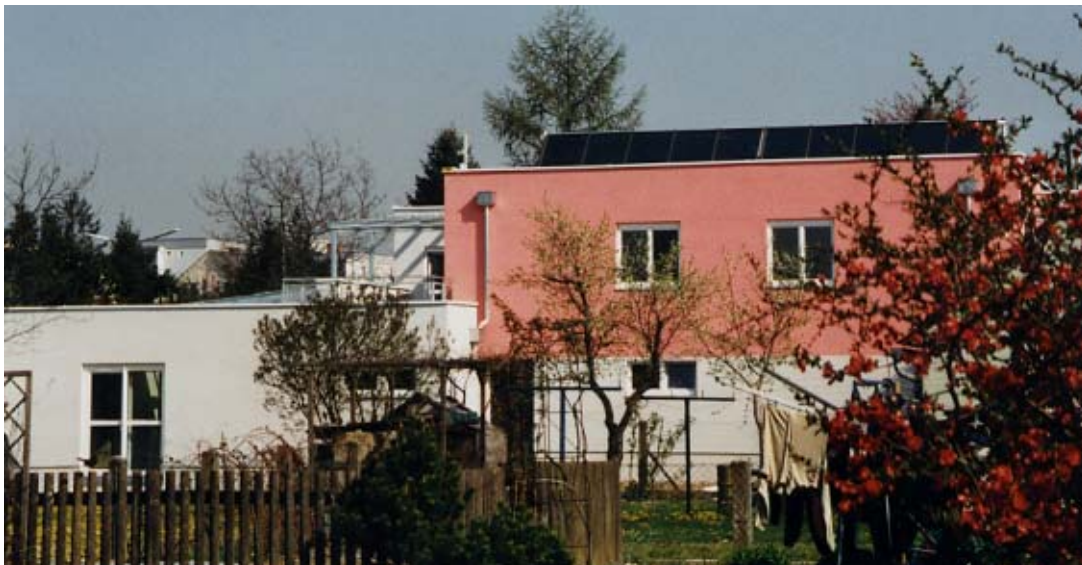
Abbildung 27: Südansicht des Demonstrationsobjektes „Nittnergasse“ nach Baufertigstellung
