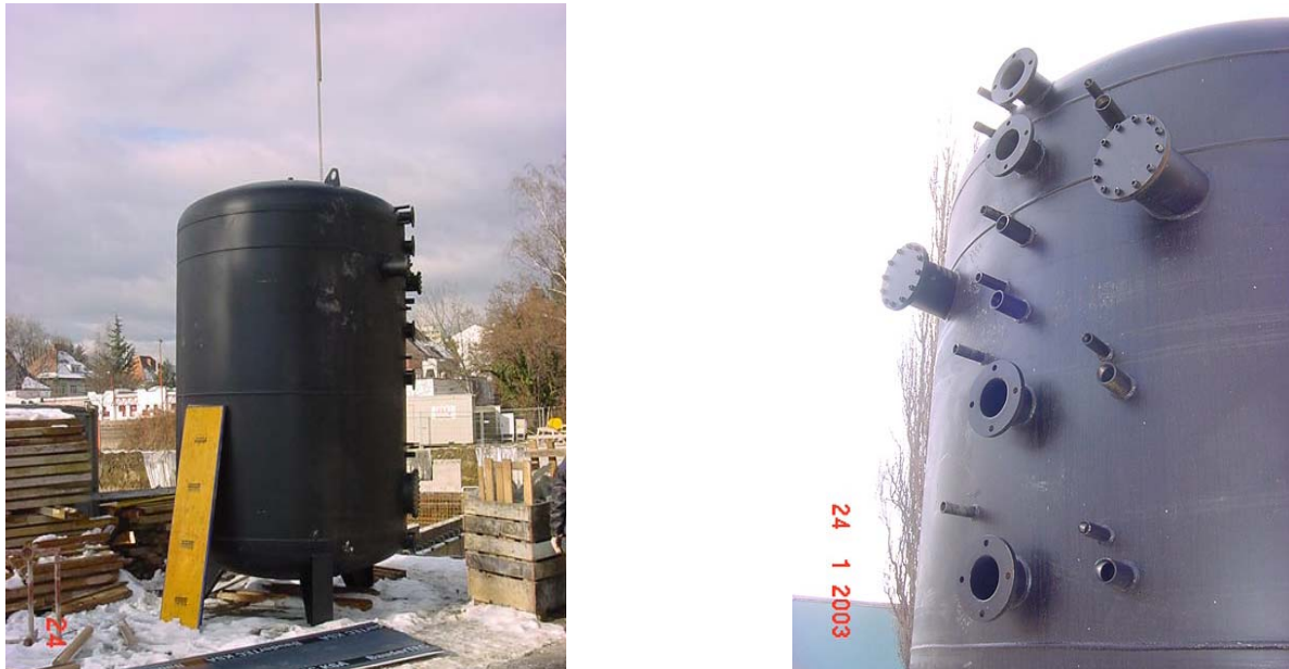
Abbildung 38: Lieferung des 20 m 3 fassenden Energiespeichers – Detailansicht rechts: hydraulische Anschlüsse im oberen Speicherbereich
