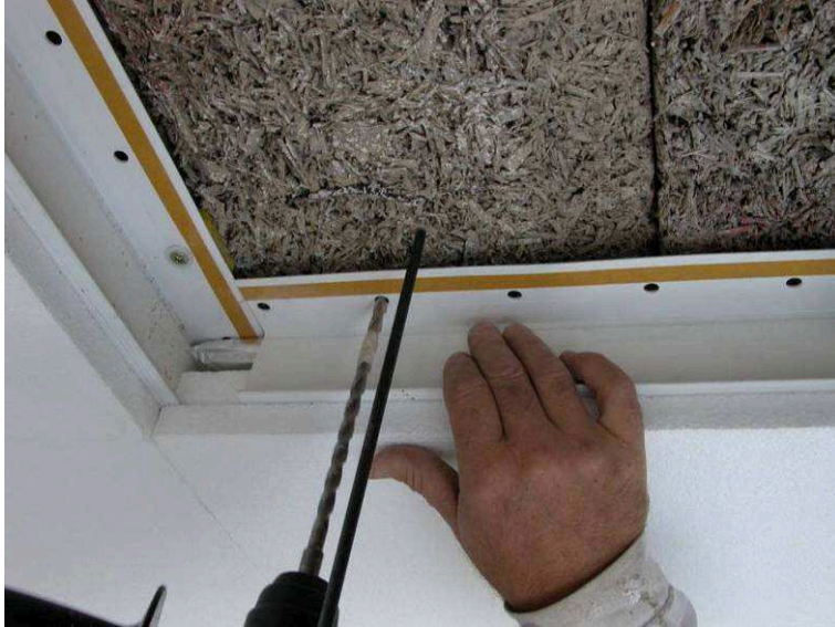
Bild 39: Die Schiene wird befestigt
