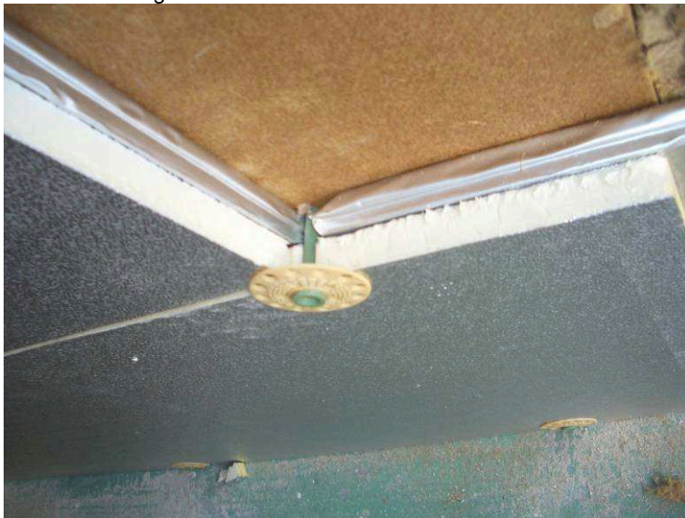
Bild 18: Schnittmodell „mechanische Befestigung“
