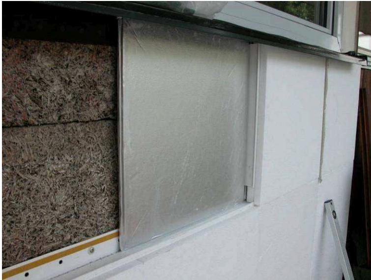
Bild 12: VIP - Schienenbefestigung
