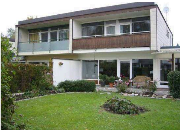
Bild 8: Wohnhaus Andre vor der Sanierung
