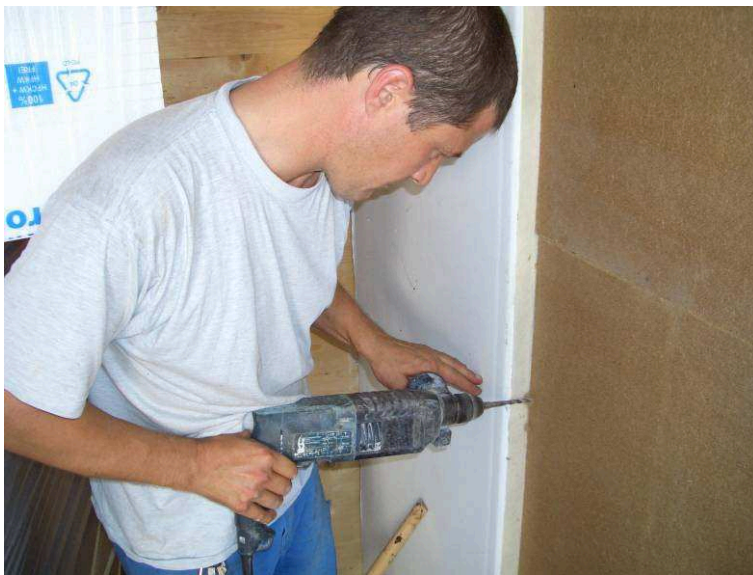
Bild 17: Bohrungen werden nach Dübelbild erstellt
