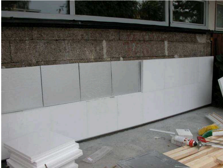
Bild 45: Teilansicht VIP – EPS Fassade
