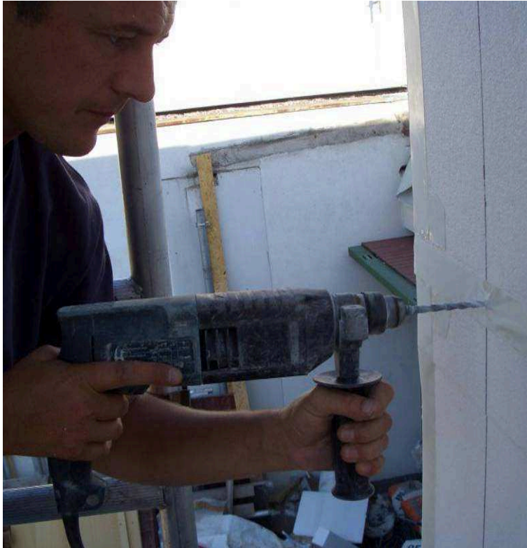
Bild 31: Die Bohrungen für die Dübel
