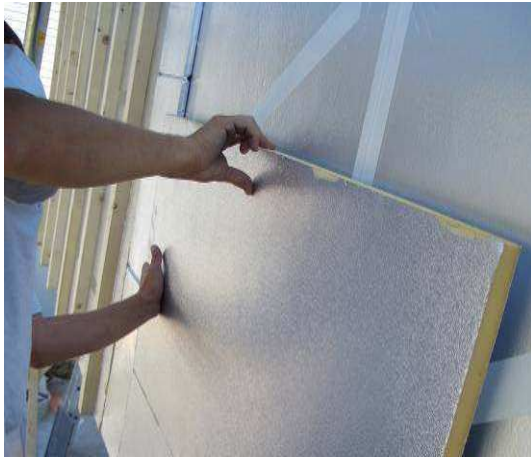
Bild 10: Roh-Fassade mit luftdichter Ebene
