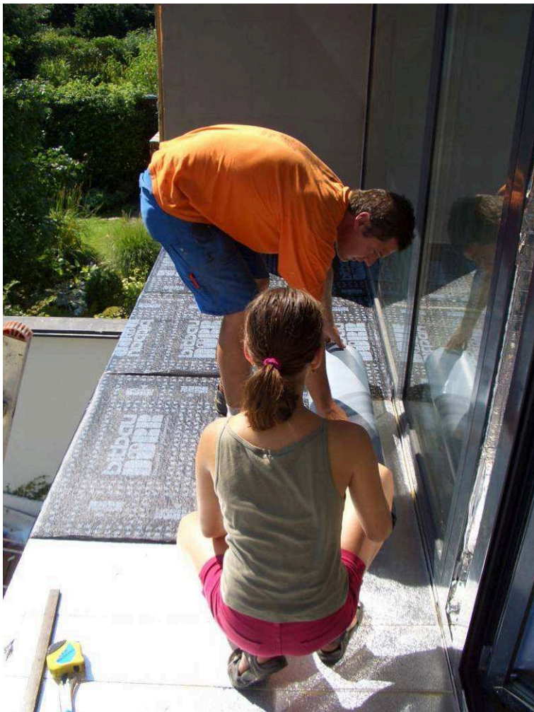
Bild 53: Die Abdichtungsbahn auf dem Balkon
