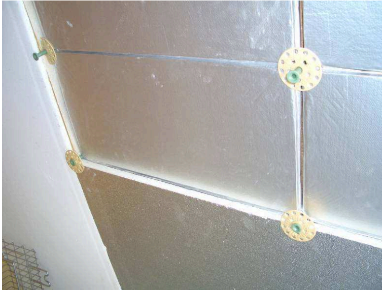
Bild 19: 2. Lage PUR Platte mit variablem Dübelteller (oben)
