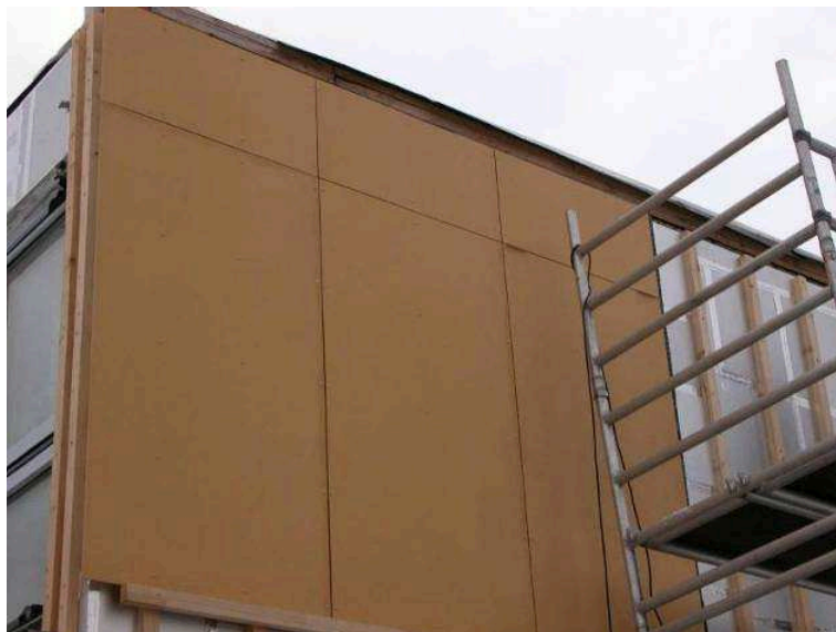
Bild 38: Nordfassade mit Cem-Board Platten
