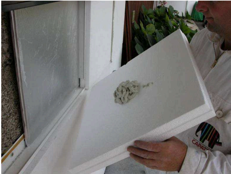
Bild 42: Die EPS Platte wird aufgebracht
