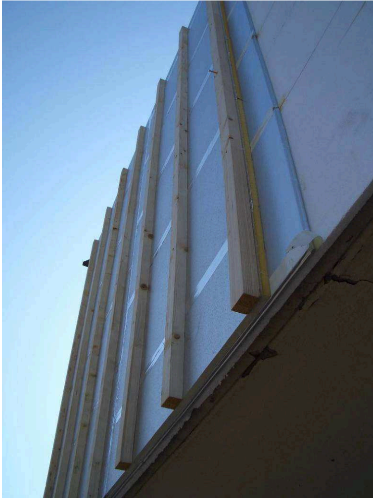
Bild 37: Nordfassade ohne Cem-Board Platten
