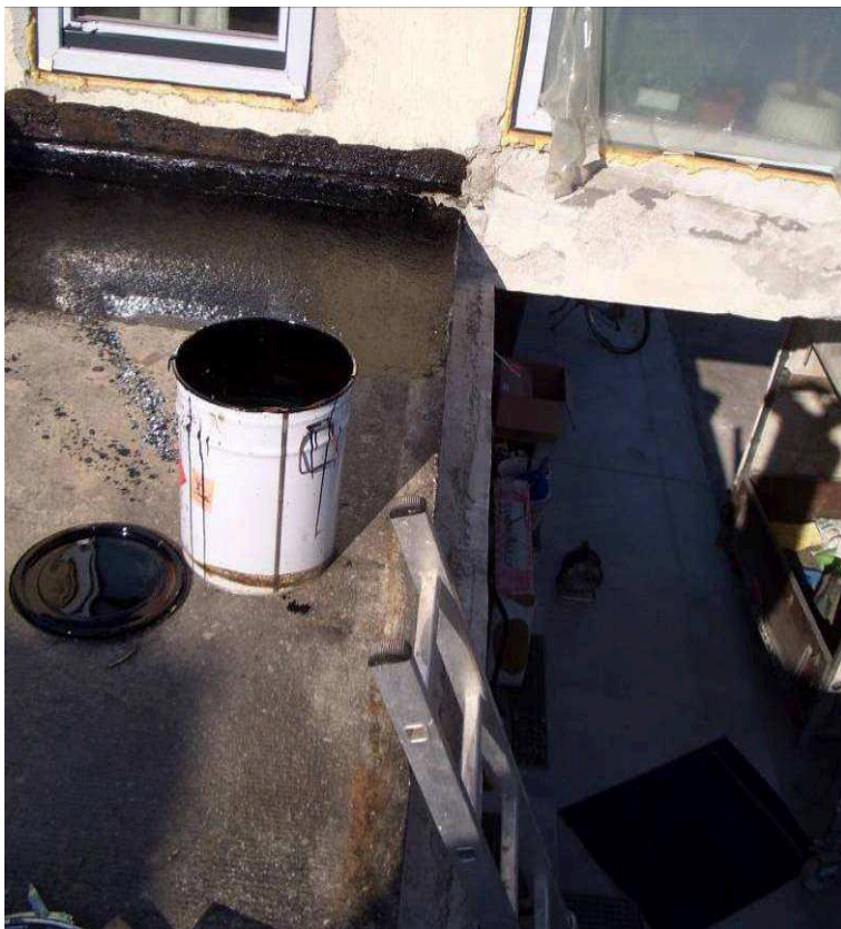
Bild 27: Die Terrasse kurz vor dem Neuaufbau
