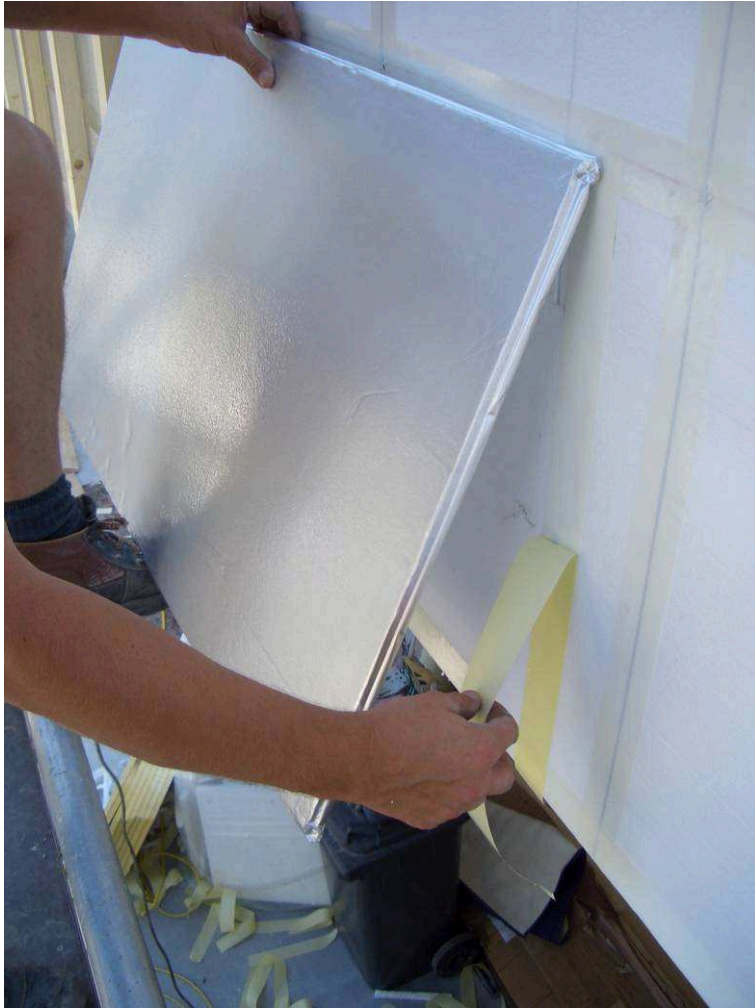
Bild 33: Die VIP wird „provisorisch“ befestigt
