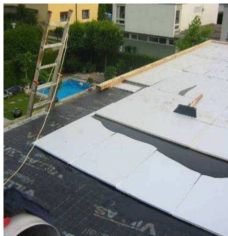
Bild 15: Aufbau der Dachdämmung
