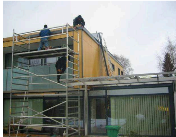
Bild 9: Wohnhaus Andre nach der Sanierung
