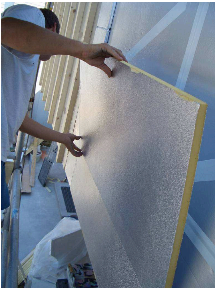
Bild 36: Die PUR Platte wird aufgebracht
