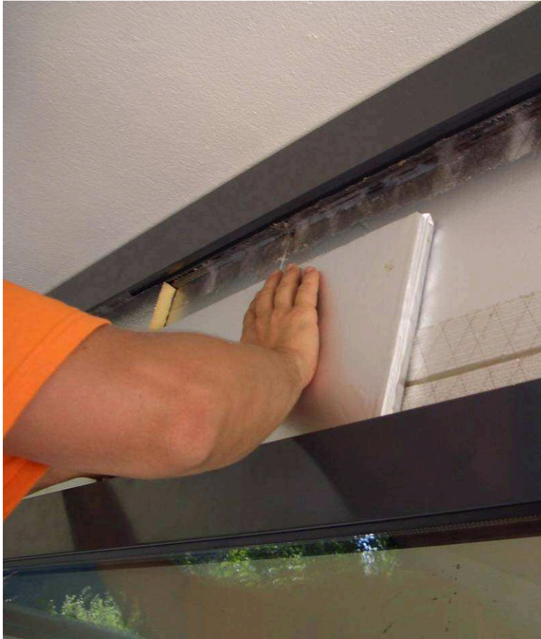
Bild 54: Die VIP wird 2-lagig in die Oberlichte eingesetzt
