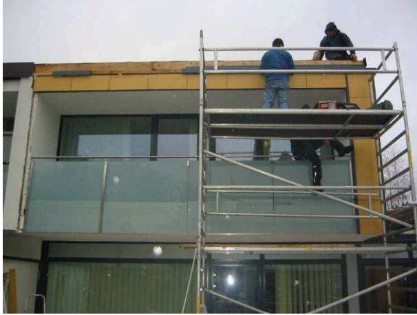
Bild 56: Die Südfassade wird komplettiert
