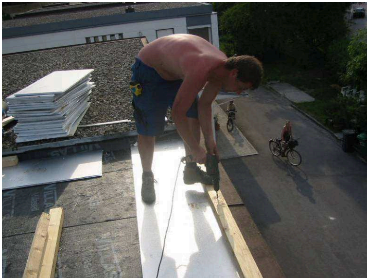
Bild 23: Die Attika Holzbohle wird aufgebracht
