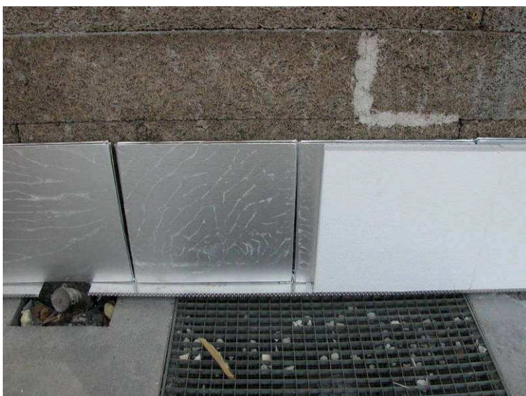
Bild 41: Die VIP in der Sockelschiene
