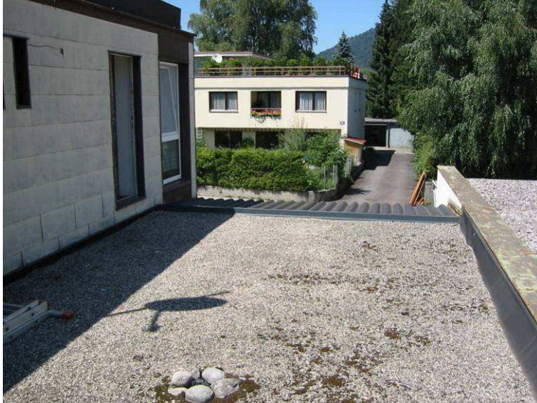
Bild 26: Die bestehende Terrasse
