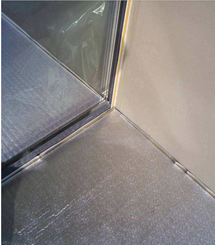
Bild 52: Anschlussdetail Balkon – Verglasung - Wand
