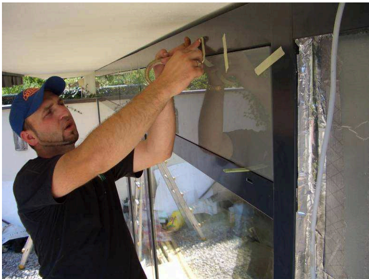
Bild 55: Die emaillierte Verglasung wird eingesetzt
