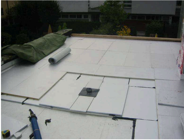
Bild 28: Die Terrasse mit der verlegten Wärmedämmung
