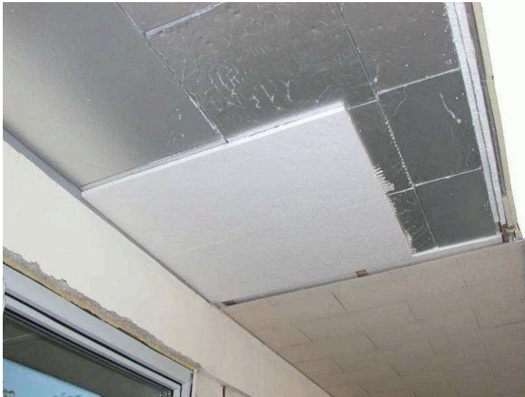
Bild 47: Direkte Verklebung VIP am Untergrund mit 2cm PS Dämmplatten
