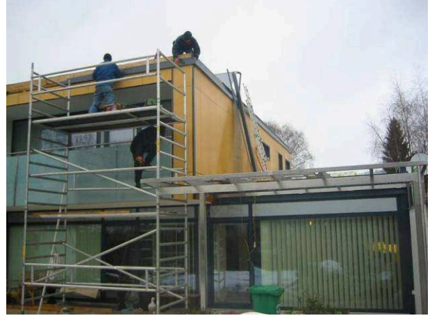
Bild 57: Die Südfassade wird komplettiert
