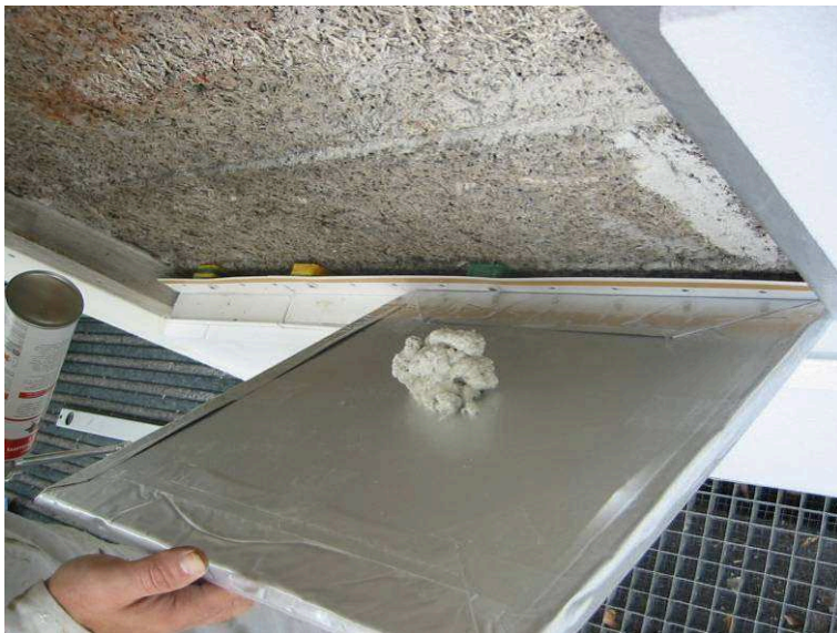
Bild 40: Die VIP wird mit PU Kleber fixiert
