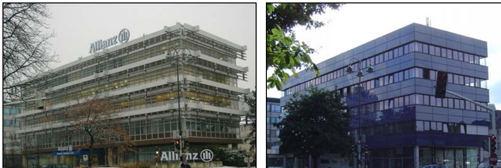
Abbildung 6: Bürogebäude in Linz vor und nach der Sanierung 16
