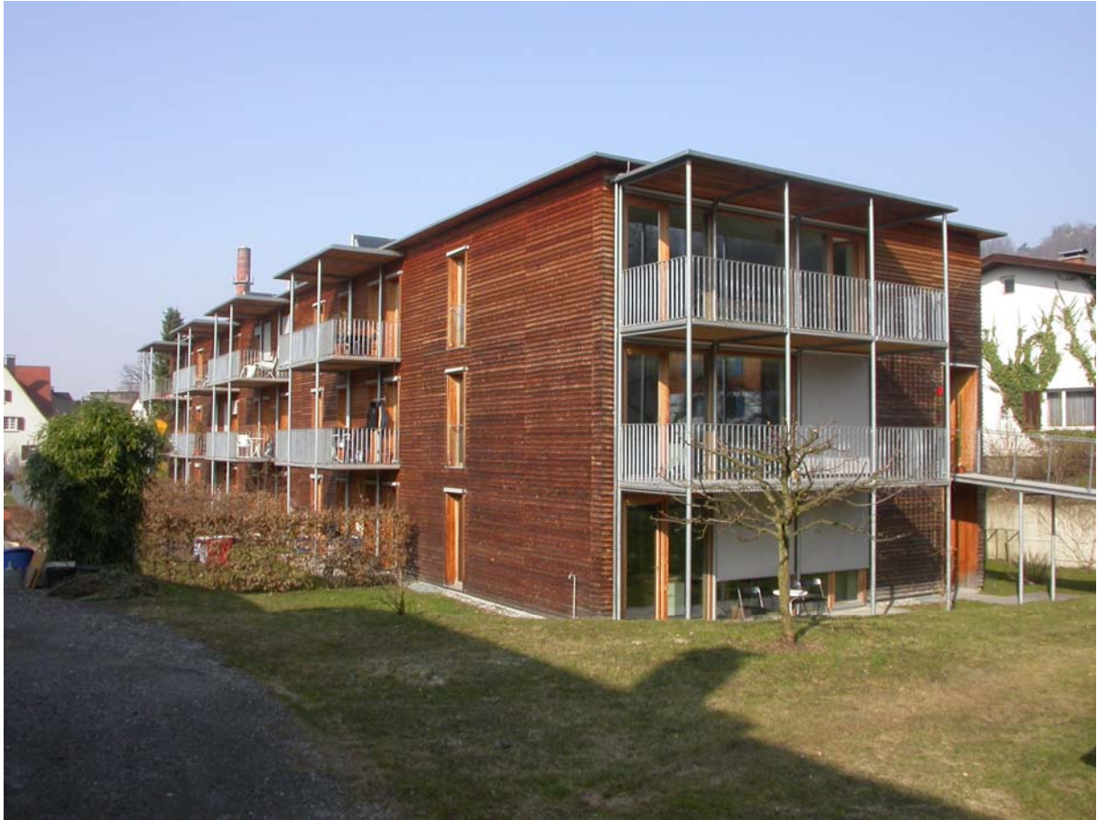
Abb. 7.2.2-1: Südansicht – Balkone und Freiflächen der Wohneinheiten, Projekt "Ölbündt"
