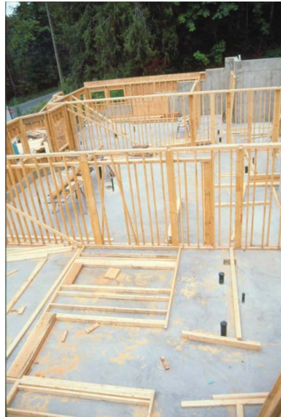
Abb. 4.4.2-1: Errichtung einer Reihenhaussiedlung in Rahmenbauweise, Vancouver Island, Kanada
