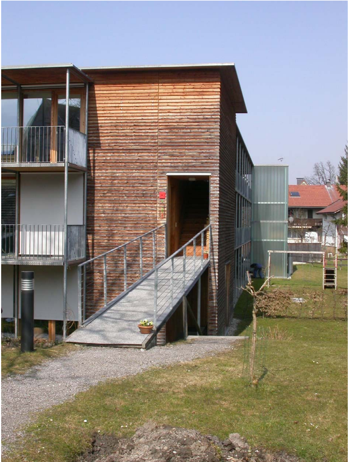
Abb. 7.2.2-2: Süd-Ostansicht – Zugangsrampe Erschließung, Projekt “Ölzbündt”
