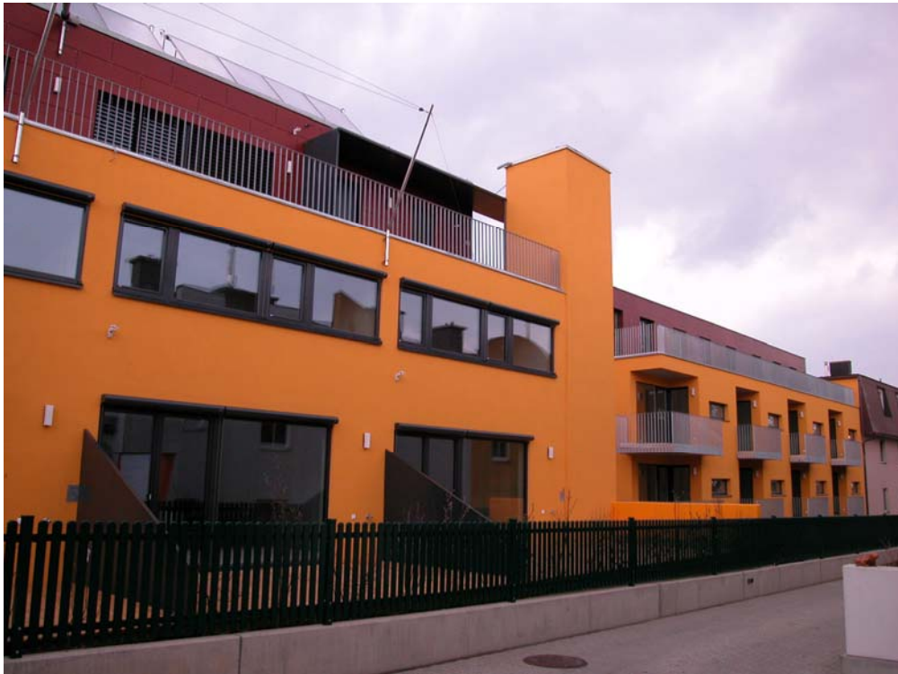
Abb. 7.1.2-1: Südansicht Bauteil 1 (Hintergrund, Niedrigenergiehaus) und 2 (Vordergrund, Passivhaus)
