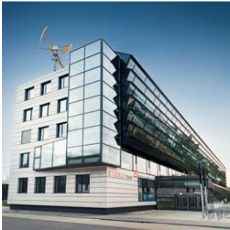
Abbildung 4: Bürogebäude ENERGYbase mit gebäudemontierter KWEA CVT-50 (Quelle: Fachhochschule Technikum Wien)
