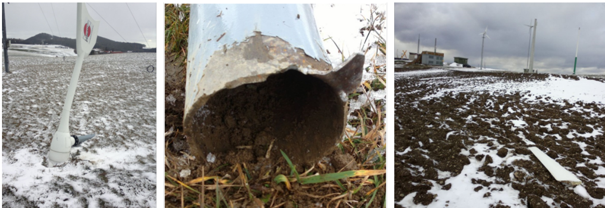
Abbildung 6: Totalschaden der KWEA Windspot am 4. Februar 2016 (Quelle: Eigene Darstellung)
