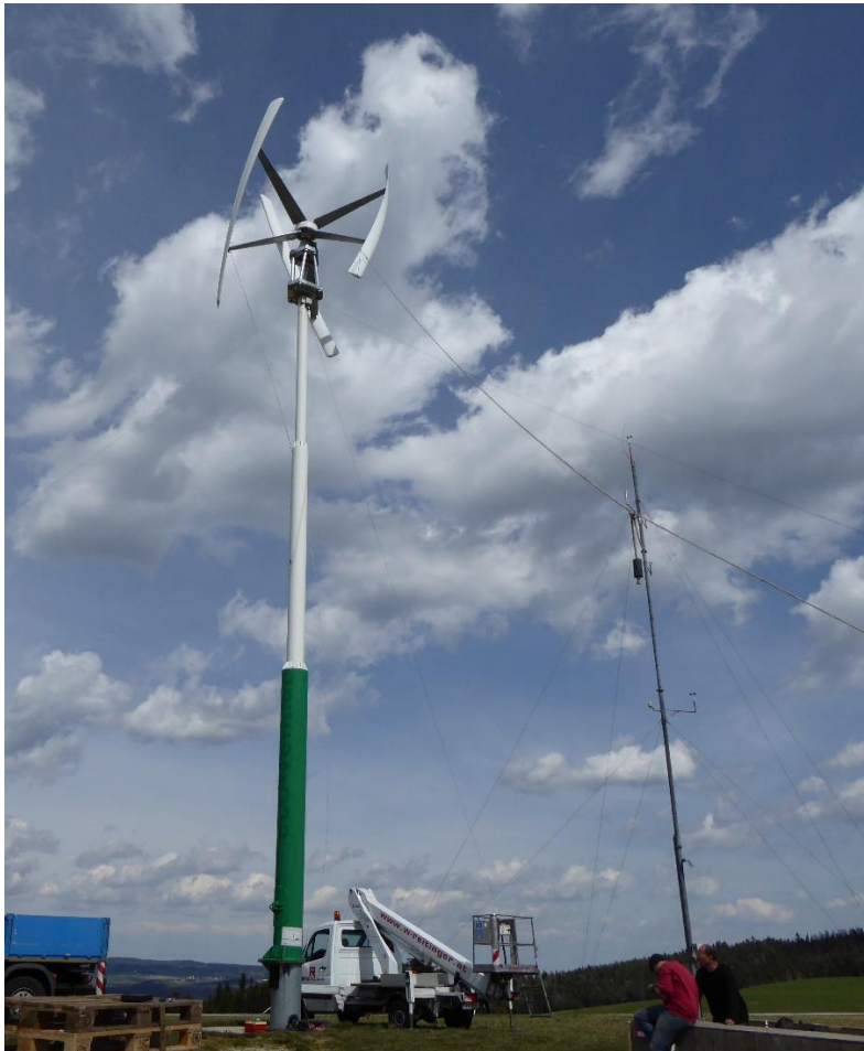
Abbildung 44: Amperius VK250 auf Kippmast, daneben der Windmessmast (eigene Darstellung)
