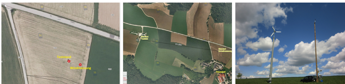
Abbildung 52: Überblick über normkonforme Prüfinfrastruktur (nach IEC 61400-11) im Energieforschungspark Lichtenegg (Quelle: Eigene Darstellung, Google Maps)
